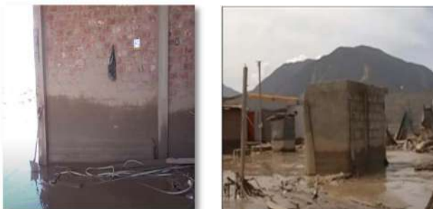
Fig. 9. Marks left by the mud flow in Pampapacta (Punta Hermosa)
